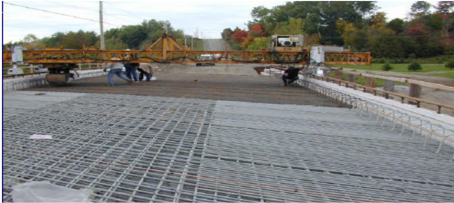
شکل ۷- نمونه ای از دال مسلح کامپوزیت با میلگرد های FRP
