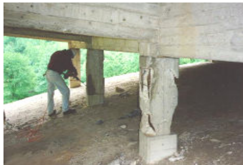
شکل ۵- ستون های یک پل قبل و بعد از مقاوم سازی با جاکت FRP
