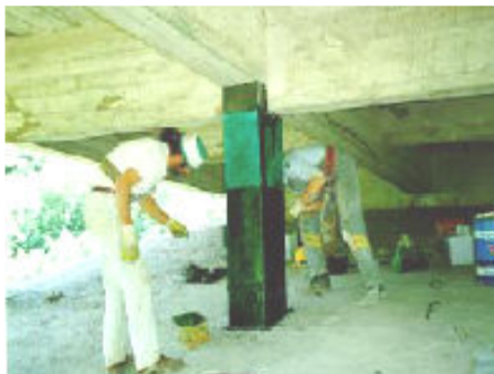
شکل ۵- ستون های یک پل قبل و بعد از مقاوم سازی با جاکت FRP
