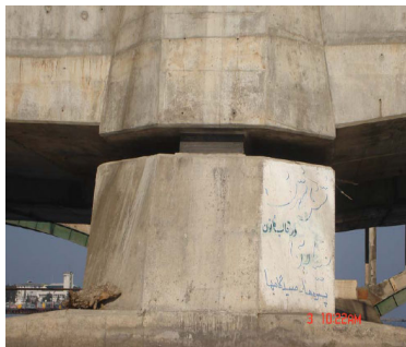
شکل ۳- تعبیه میراگر در محل تکیه گاه پل
