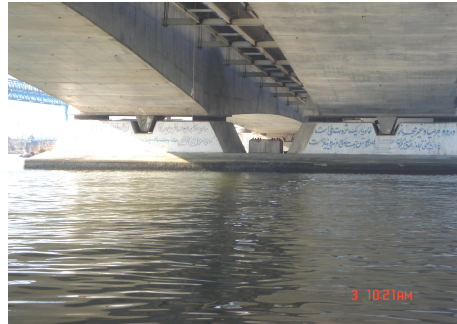
شکل ۳- تعبیه میراگر در محل تکیه گاه پل
