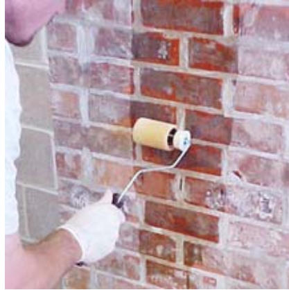
Fig. 3.2. Application of the primer
