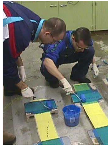
(d) Application of second coat of saturant
