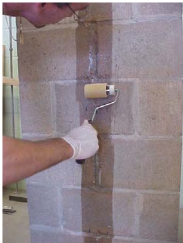
(a) Application of primer
